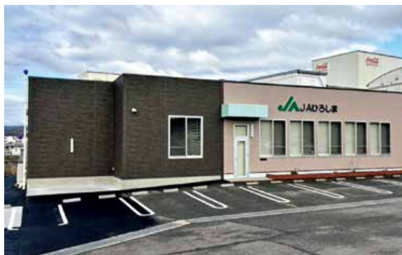
▲増築改修後の本郷中央支店
