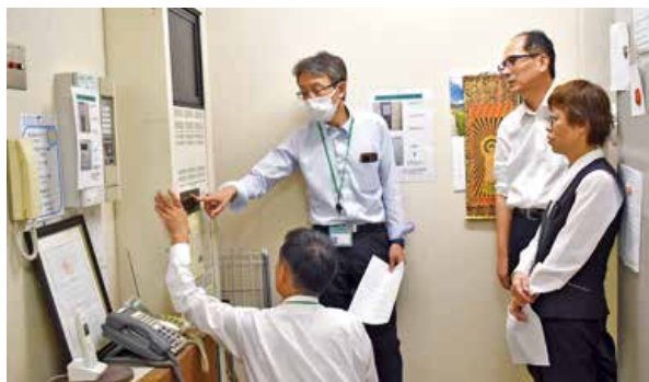
▲自動火災報知機の確認を行ないました
